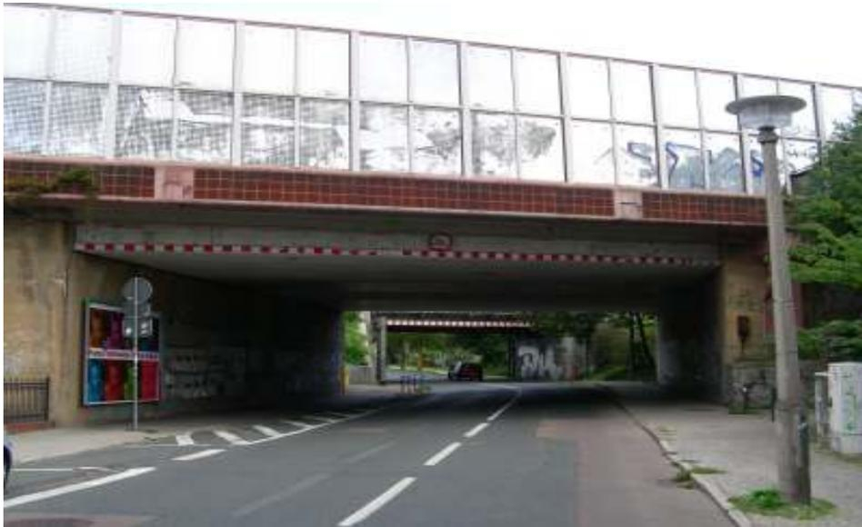
Bei dem Bestandsbauwerk handelt es sich um eine Spannbetonkonstruktion aus dem Jahre 1968. Der schiefwinklige Überbau ist zweiteilig und wird durch 2x10 Spannbetonfertigteilträger BT 70 der 1. Generation gebildet. Die Balken wurden in Segmentbauweise hergestellt und bestehen aus jeweils 10 einzelnen Hohlkastenfertigteilen, die mit je 6 Spanngliedern im nachträglichen Verbund zusammengespannt wurden.
