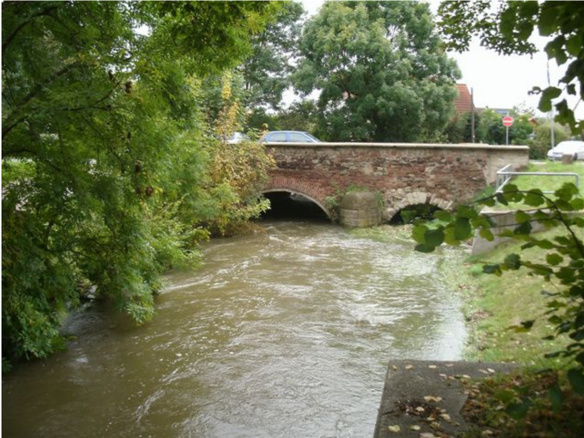
Reidebrücke B 6 (Bruckdorf)
