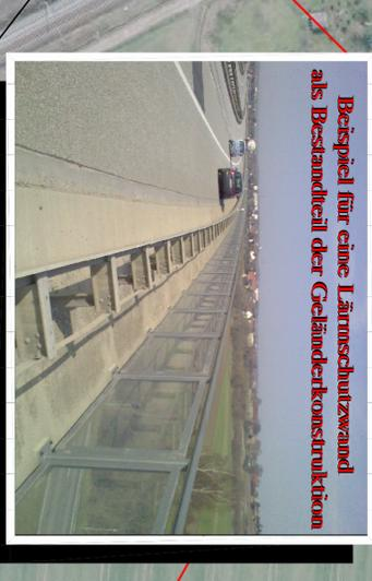
Beispiel für eine Lärmschutzwand als Bestandteil der Geländekonstruktion
