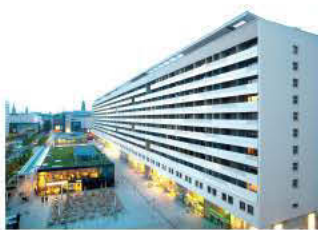
Wohn- und Geschäftshaus „Prager Zeile“ St.- Petersburger-Straße 26 - 32, Dresden
