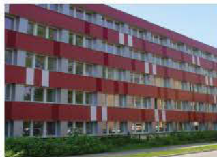
Studentenwohnheim Staatliche Studienakademie Glauchau Fassaden- und Innensanierung
