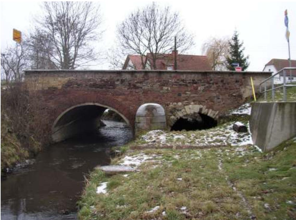
Das im Jahr 1900 errichtete Brückenbauwerk besteht aus 2 Gewölbebögen, einer Stromöffnung mit 5,29 m Stützweite und einer Flutöffnung mit 3,40 m Stützweite.
