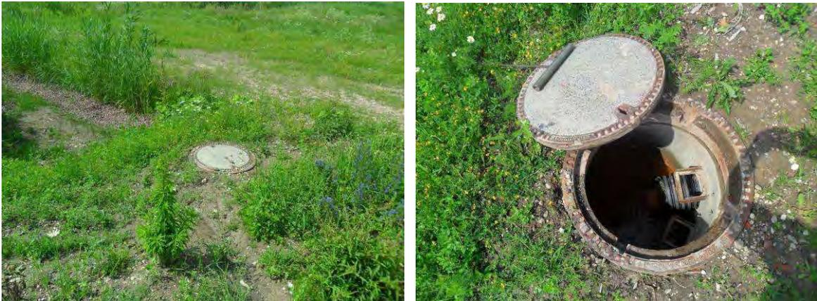
Abb.: Endschacht mit „Auslauf“ Entlastungsdrainage M24, südlich des Plangebietes
