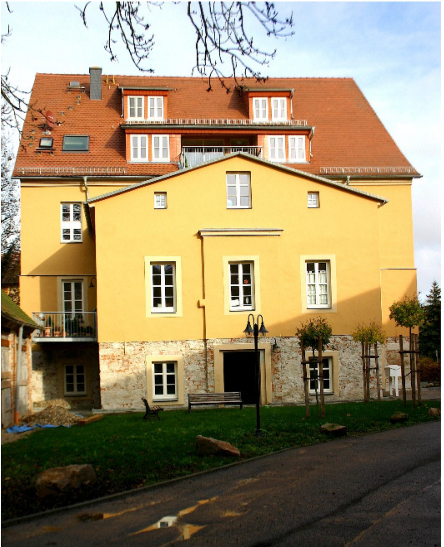
Nr. 7: Wohnhaus, ehemalige Wassermühle des Vorwerks Gimritz; An der Peißnitzinsel 1, 06108 Halle (Saale), Westseite. Umlaufend steinsichtiges Mauerwerk in ca. 2 m Höhe - Wasserschaden des Hochwassers vom Sommer 2013.
