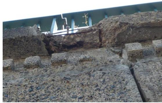
Des Weiteren weist das Bauwerk in der oberen Ebene, vor allem im Bereich der Querfugen und der Längsfuge große Ausbrüche der Straßenbefestigung und defekte Fugen auf.
