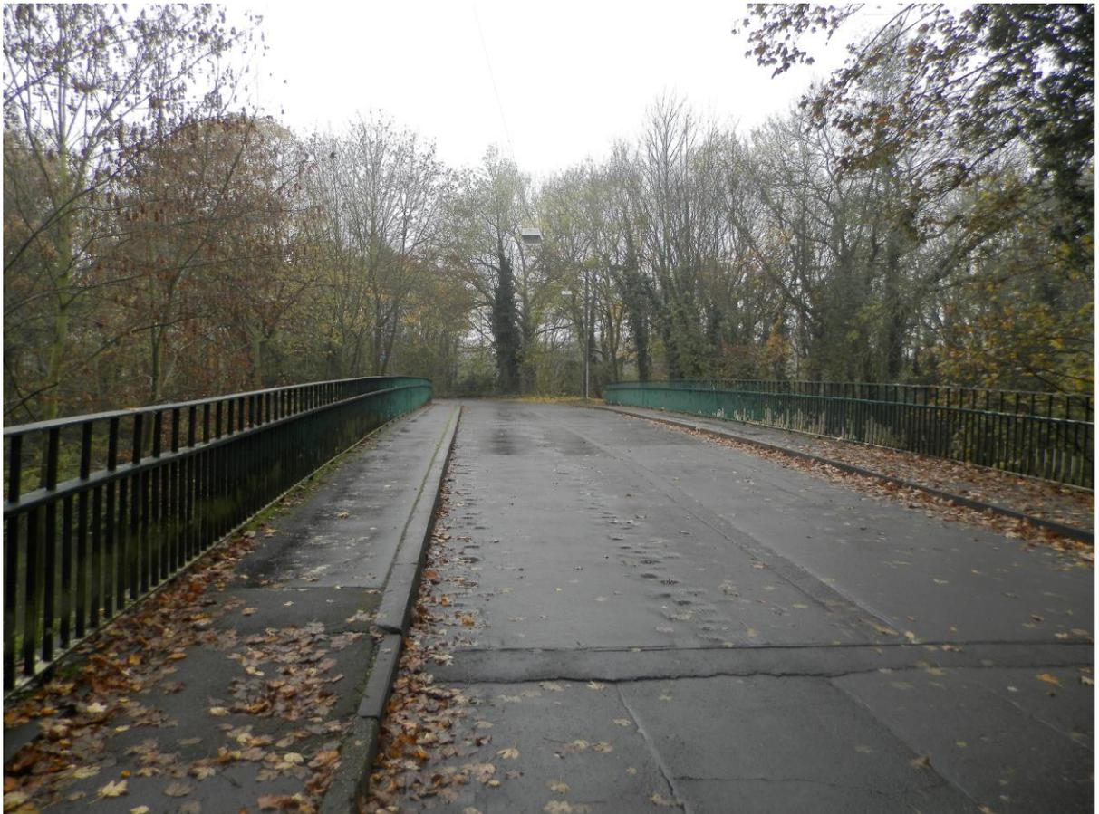
Bei dem im Jahre 1969 errichteten Brückenbauwerk handelt es sich um eine Spannbetonbrücke mit im Querschnitt 3 nebeneinander liegenden Hauptträgern, welche durch eine 20 cm dicke Fahrbahnplatte miteinander verbunden sind. Die Stützweite beträgt 34,50 m.
