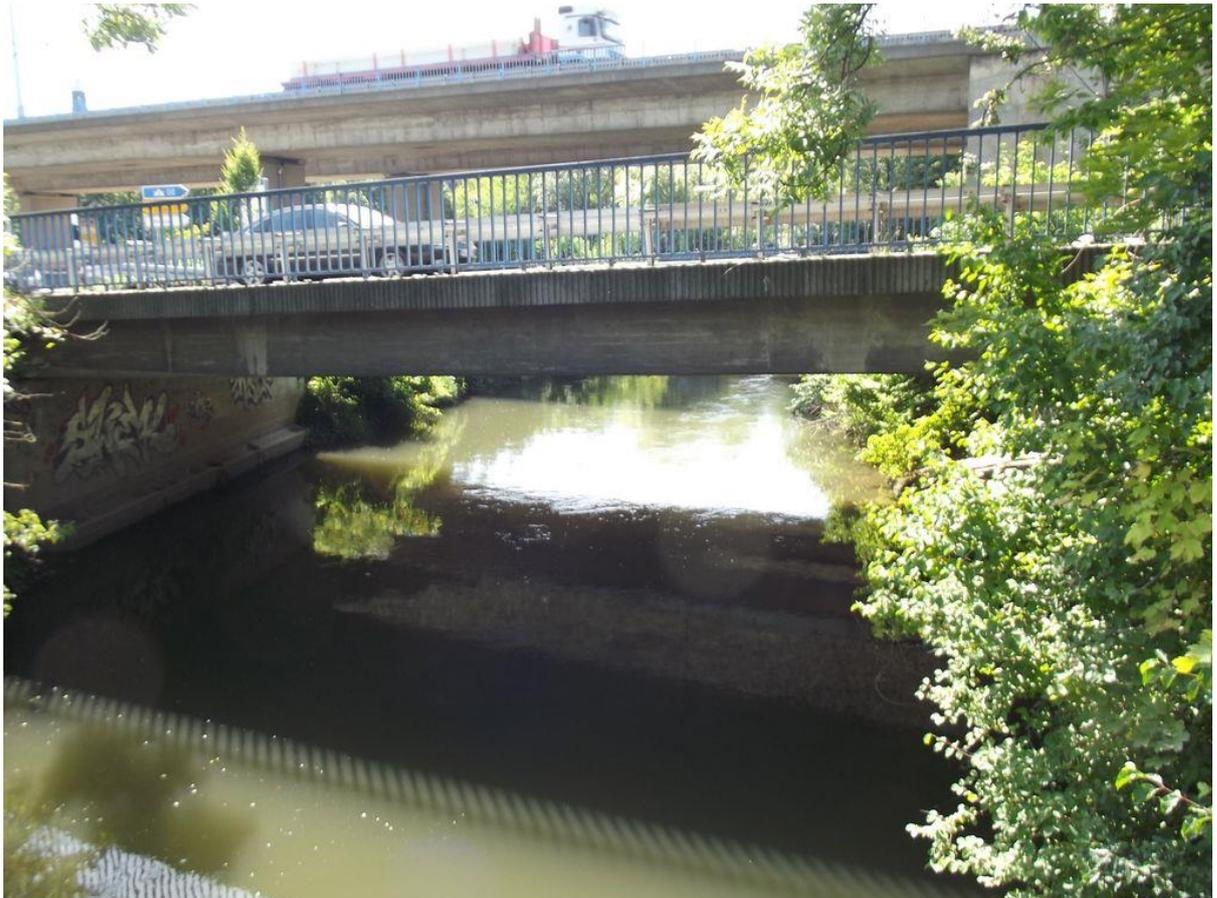
Bei dem im Jahre 1969 errichteten Brückenbauwerk handelt es sich um eine Stahlbetonplattenbrücke.
