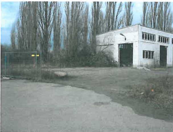
Abb. 3 Hallenaltbau im Osten (Grenzstraße)
