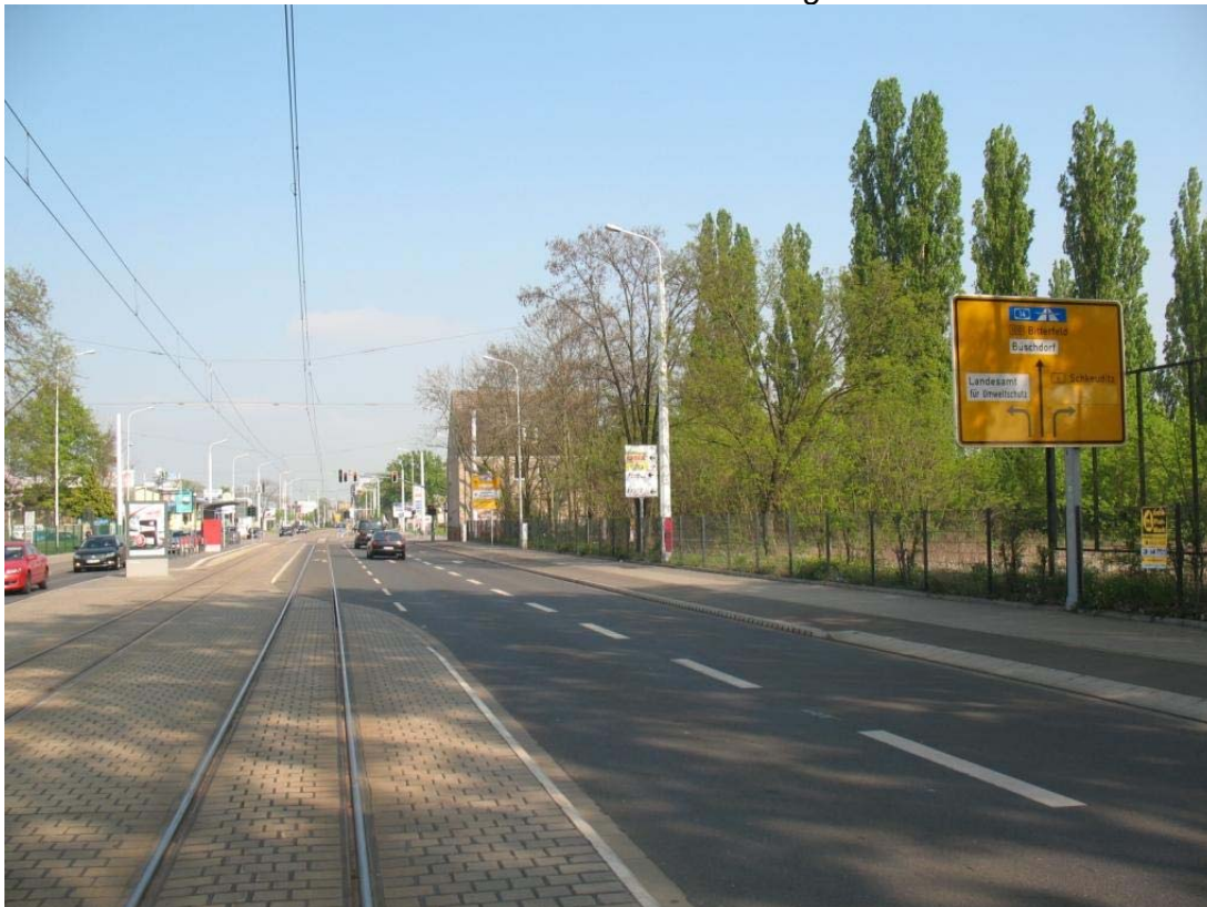
Abb. 1: Zufahrt Delitzscher Straße West an der Kreuzung mit der Grenzstraße
