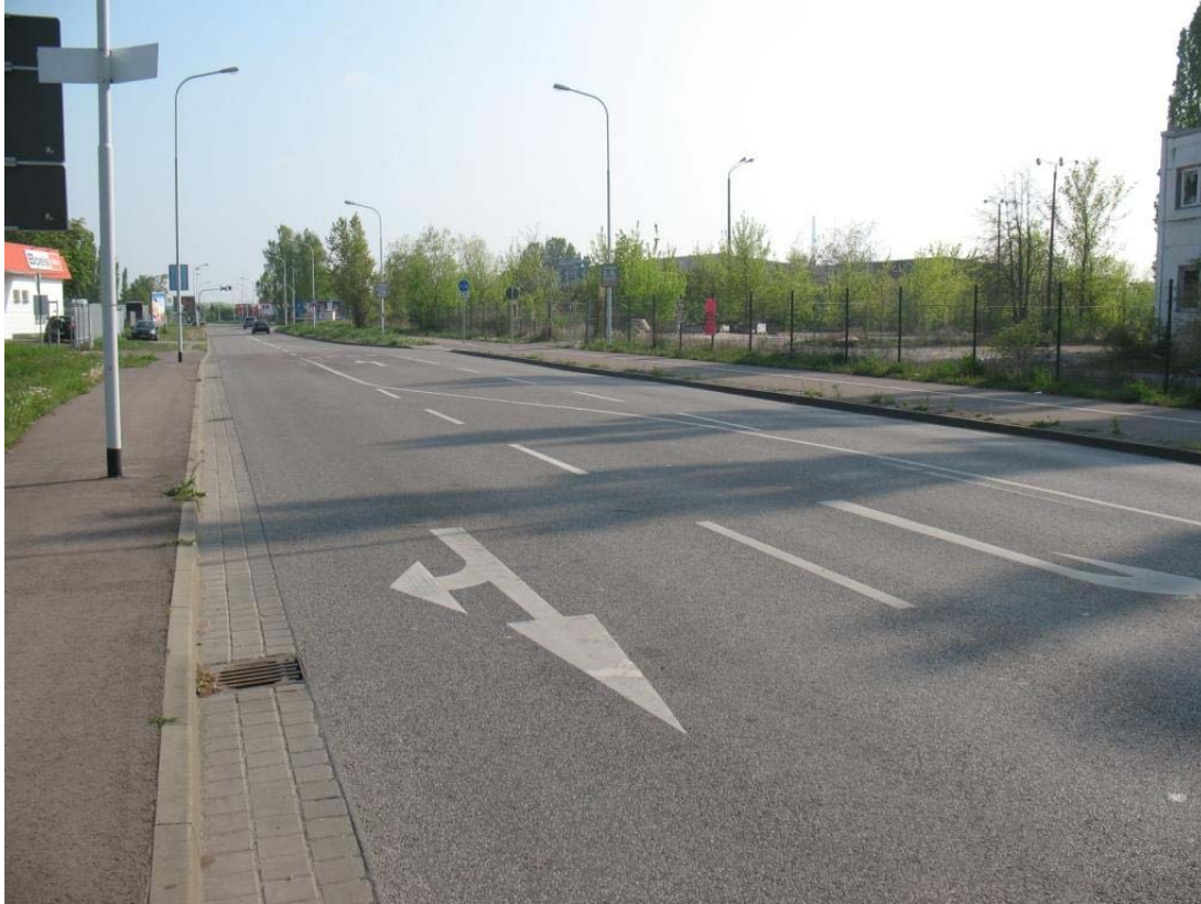
Abb. 5: Ausfahrt Grenzstraße Süd am Knotenpunkt Delitzscher Straße / Grenzstraße
