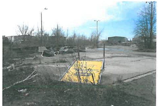
Abb. 2 Blick von Osten auf die Baufläche
