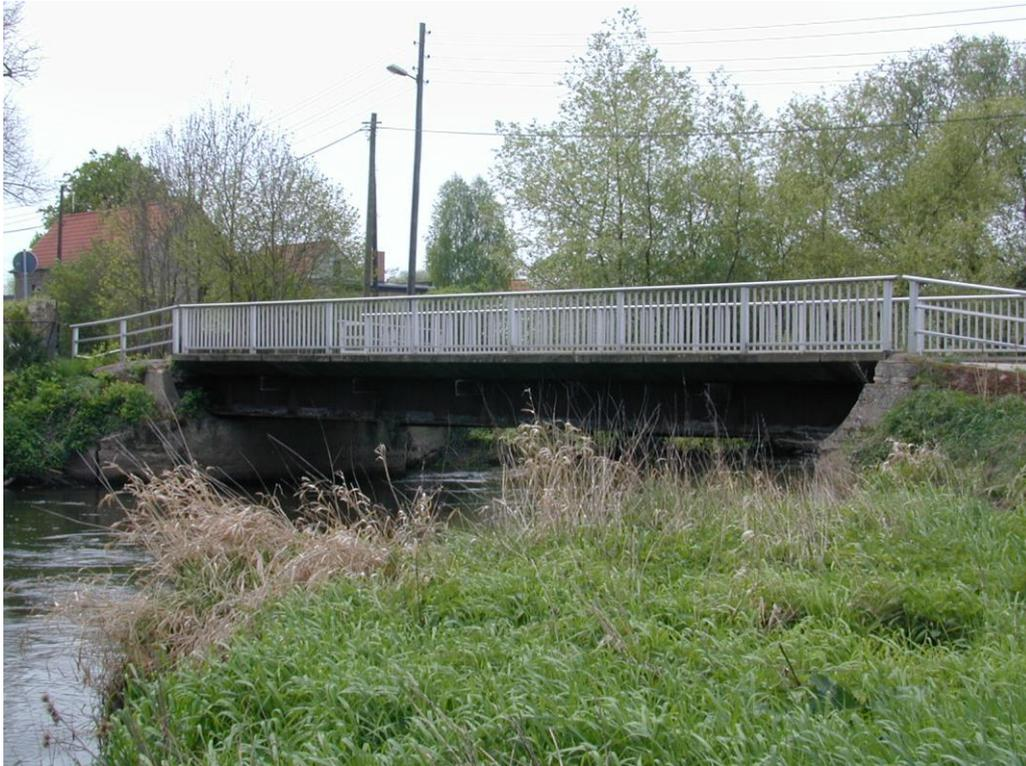
Die bestehende Brücke besteht aus 3 geschweißten Hauptträgern aus Stahl mit aufgelegten Stahlbetonfertigteilen. Widerlager und Flügel bestehen aus unbewehrtem Beton und stammen noch von dem Vorgängerüberbau aus Holz.
