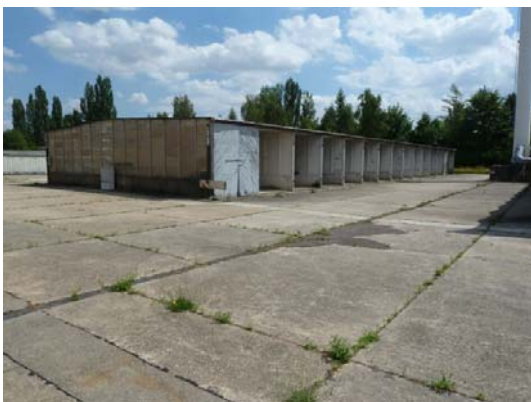
betonierter Garagenkomplex im Südteil des UR
