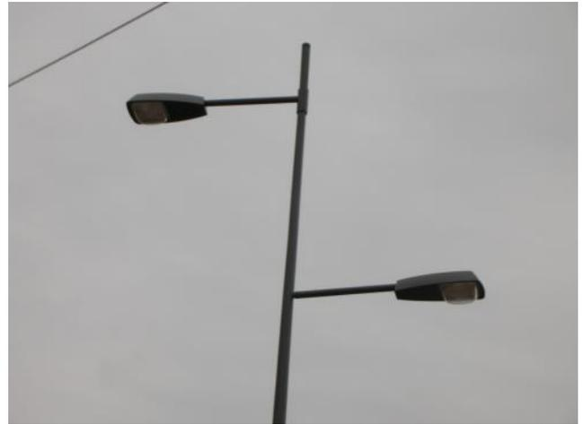
Geradliniger (92,5°) Leuchtausleger + 50cm Überstand des Mastes + Kofferleuchte (Philips) Bsp. Steintor
