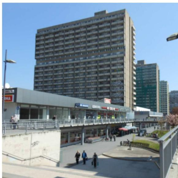
Zur Abschätzung der vorhandenen Raumkapazität wurden zunächst die im Stadtarchiv vorhandenen Raumpläne gesichtet und in Zusammenarbeit mit der Firma OBERMEYER Planen + Beraten GmbH aufgearbeitet. Das Gebäude ist auf einem Rastersystem aufgebaut und hat insgesamt 21 Geschossebenen.
