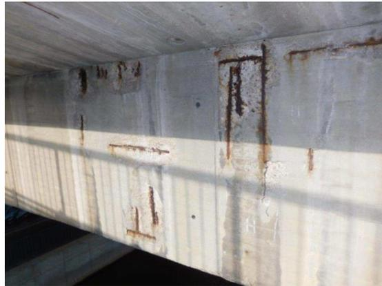
Die Schäden unterscheiden sich in Hohlstellen, Betonabplatzungen mit freiliegender Bewehrung (auch Spannglieder), Rissen und Kiesnestern.
