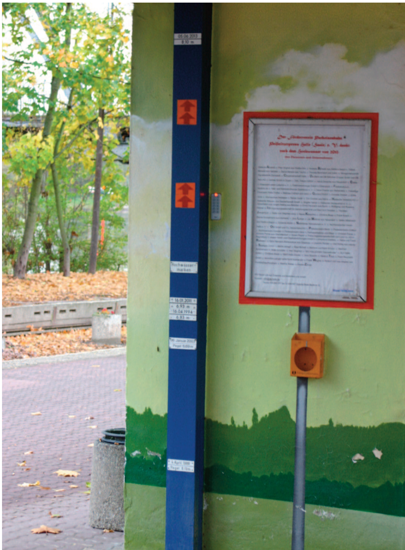
Nr. 10: Parkeisenbahn - Peißnitzexpress, Stahlstütze des Bahnhofdaches mit fünf HWM
