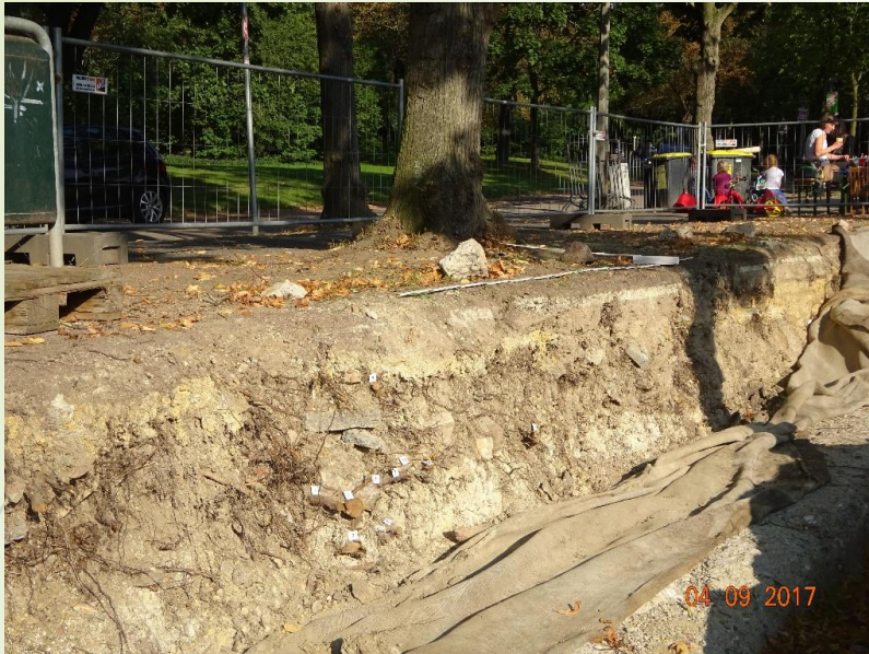
Wurzelschäden durch Mauerabriss bei Baum 154,
