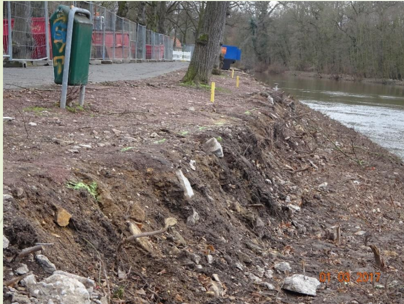
Wurzelschäden durch Mauerabriss im Bereich Baum 105 u. ff.,
