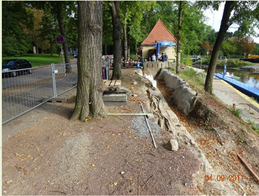
Wurzelschäden durch Mauerabriss bei Baum 153,
