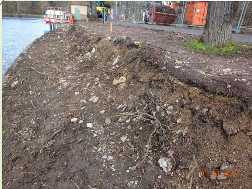
Wurzelschäden durch Mauerabriss im Bereich Baum 105 u. ff.,
