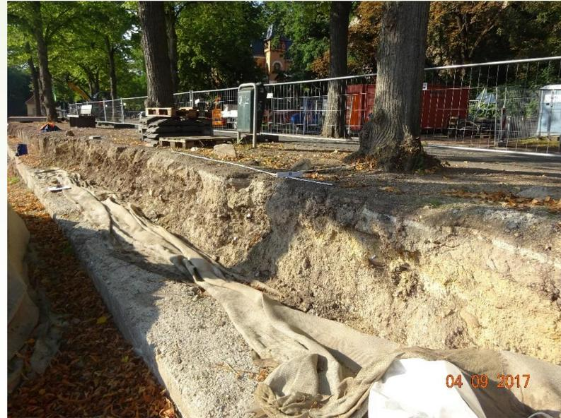
**Wurzelschäden durch Mauerabriss bei Baum 154,**
