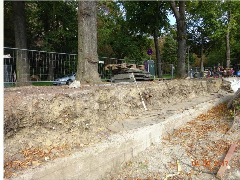
**Wurzelschäden durch Mauerabriss bei Baum 153,**
