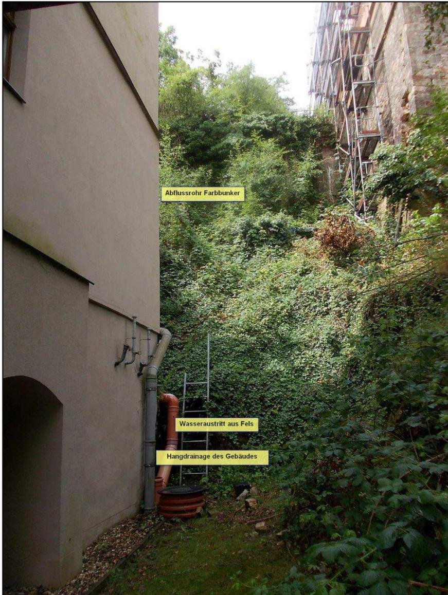
**Bild 6.1-2:** Blick auf den Austrittsbereich und die an Gebäude 4 angrenzende Wand, die bis zum Farbbunker reicht. Der Austritt ist komplett überwuchert, befindet sich aber etwa in der Flucht des Wohngebäudes links.
