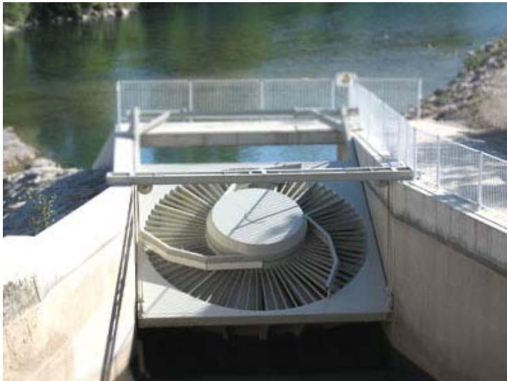
**Bild 3** Unterswasserturbine (Prinzip)
