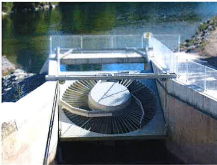
Bild 2 Unterwasserturbine (eingebaut)
