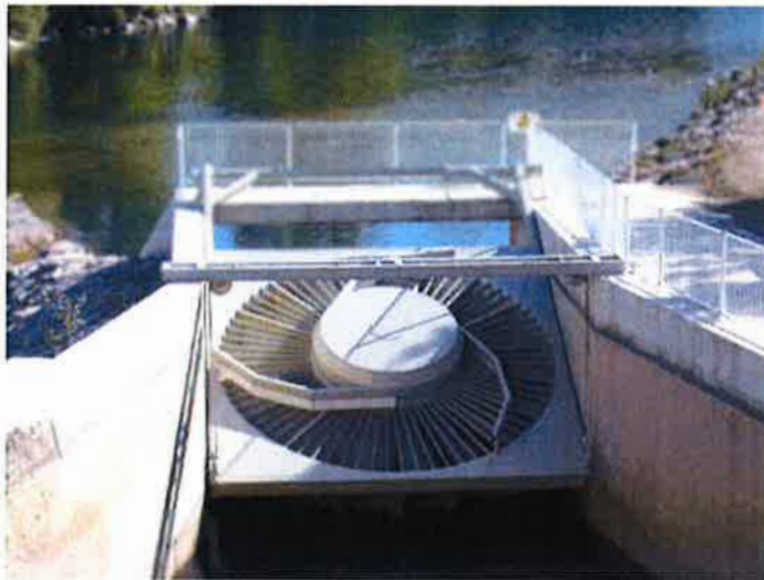
Bild 2 Unterwasserturbine (eingebaut)
