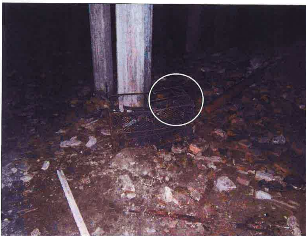
Foto 2: Sammler 2 Kellerraum, angrenzend an Raum mit Becken (siehe Foto 4). Der Sammler wurde an einem Metallbox kurz über dem Fußboden befestigt.
