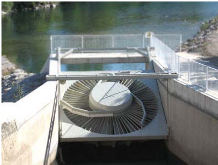
Bild 2 Unterwasserturbine (eingebaut)
