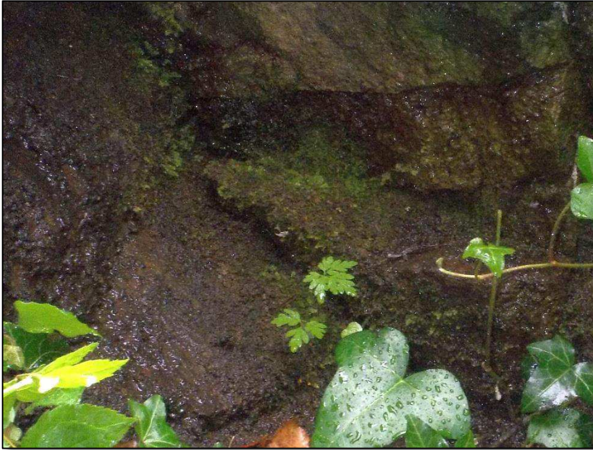
Bild 6.1-1: Wasseraustritt zwischen Wohngebäude und Gebäude 4.
