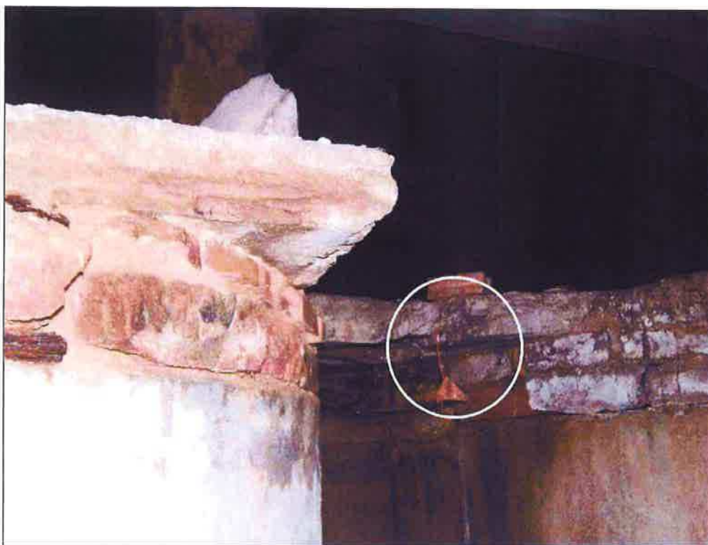
Foto 4: Sammler 4 Kellerraum mit großen Becken, nördlich des Heizungskellers. Der Sammler wurde zwischen zwei Becken befestigt.
