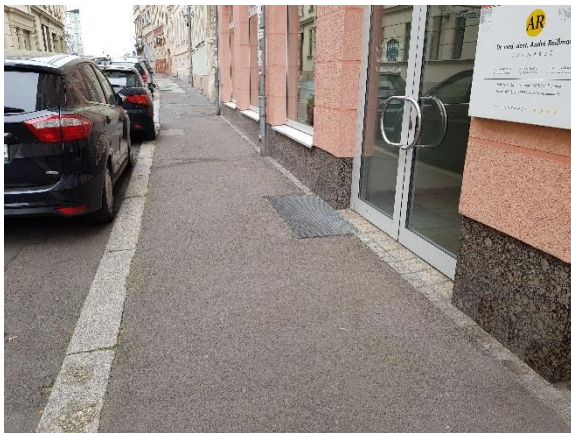
Barfüßerstraße Gehweg Ost Blick in Richtung Schulstraße
