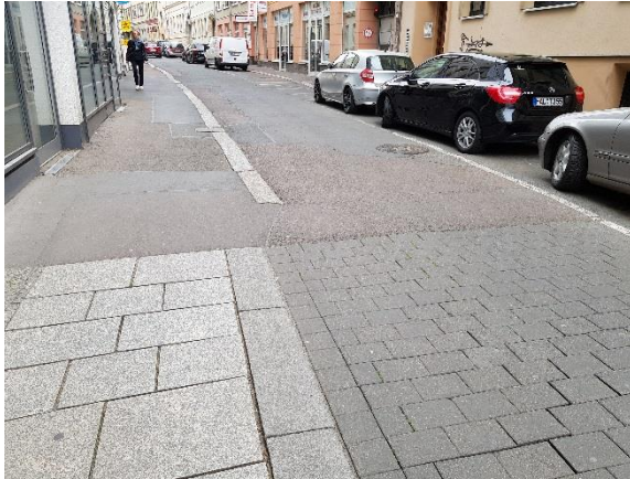
Barfüßerstraße Fahrbahn Blick in Richtung Schulstraße
