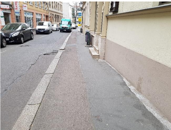
Barfüßerstraße Gehweg West Blick in Richtung Große Steinstraße
