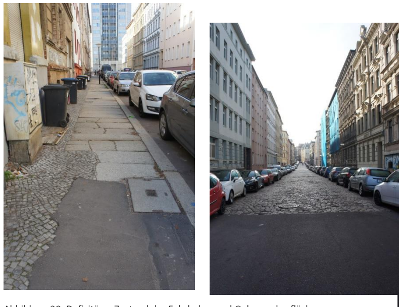
Abbildung 30: Defizitärer Zustand der Fahrbahn- und Gehwegoberflächen (links: Friesenstraße, rechts: Meckelstraße), Quelle: complan Kommunalberatung
