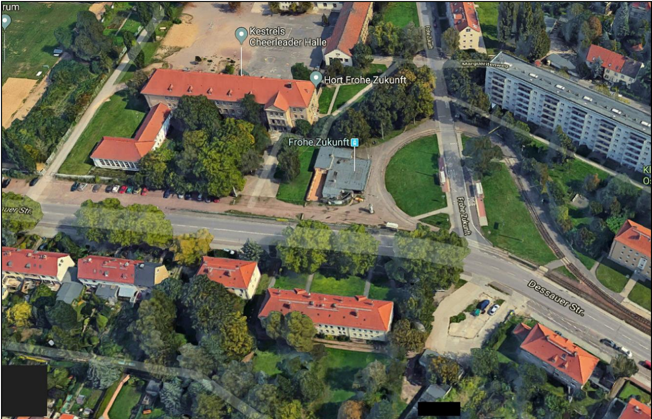
Platzbereich Frohe Zukunft mit Straßenbahnschleife und Wartehalle, Grundschule
