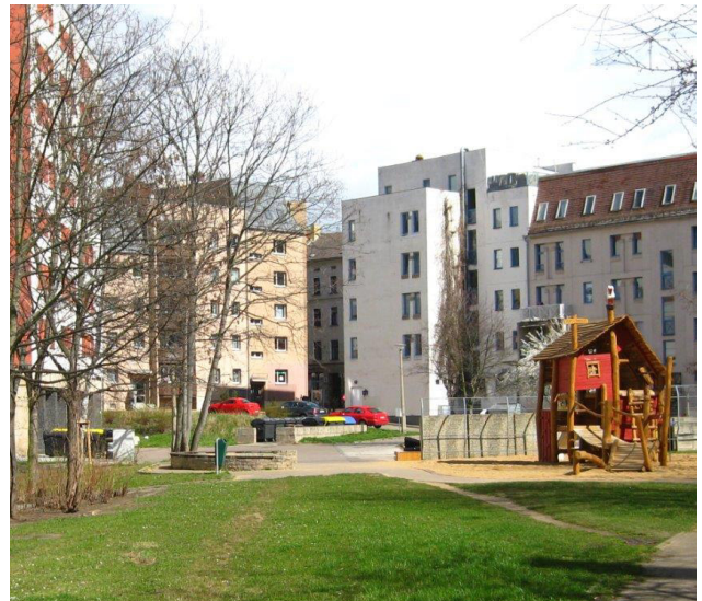
↑ Der Spielplatz „Alte Schmiede“ liegt im Quartier Schülershof. Die Wohnanlagen aus der Epoche des sozialischen Wohnungsbaus verfügen im Blockinnenbereich über qualitätsvolle Frei- und Grünräume. (4)
