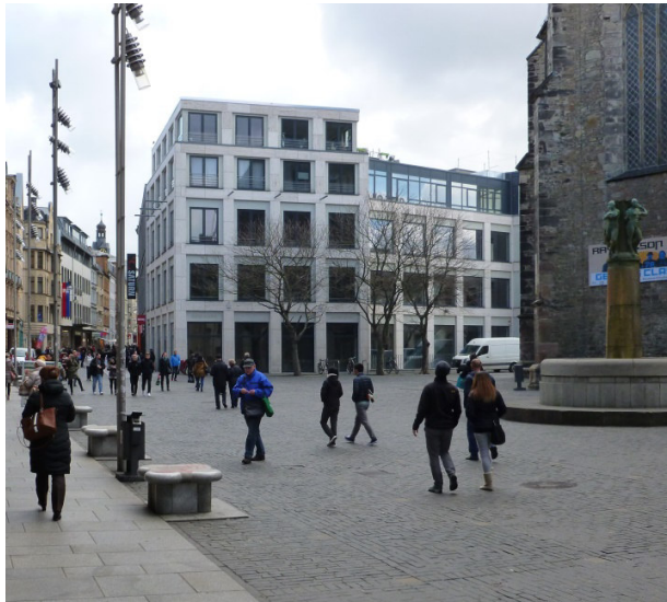
↑ Neubau Leipziger Straße 95: Die ruhig gegliederte Natursteinfassade des kubischen Baus reagiert auf die städtebauliche Situation gegenüber der Ulrichskirche. (4)
