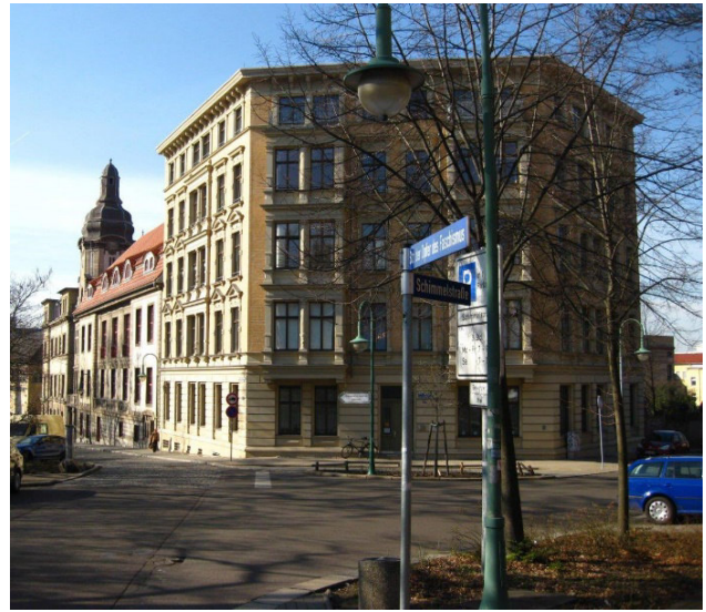
↑ Gründerzeitliche Eckbebauung mit reich verzierter Fassade, Erkern und Dekor an der Straße der Opfer des Faschismus/Schimmelstraße (4)
