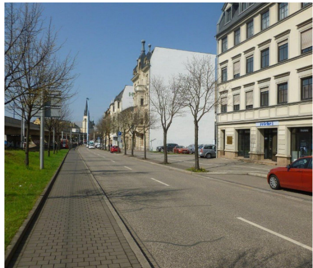
↑ Waisenhausring in Richtung Franckeplatz: Die Stadtgestalt ist verletzt und es fehlt ein Lückenschluss. Die nicht abgegrenzte Baulücke beeinträchtigt die Stadtgestalt. (4)
