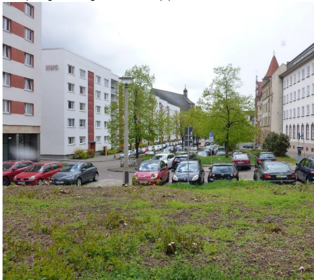
↑ Blick in den Schülershof in Richtung Moritzkirche: Auf der linken Seite befinden sich die ältesten Gebäude in Plattenbauweise der Altstadt. Diese Gebäude orientieren sich weder in Kubatur, noch entsprechend des Stadtgrundrisses an Ortsbild und Stadtgestalt der Altstadt. Hier besteht kein langfristiger Erhaltungsanspruch. (4)
