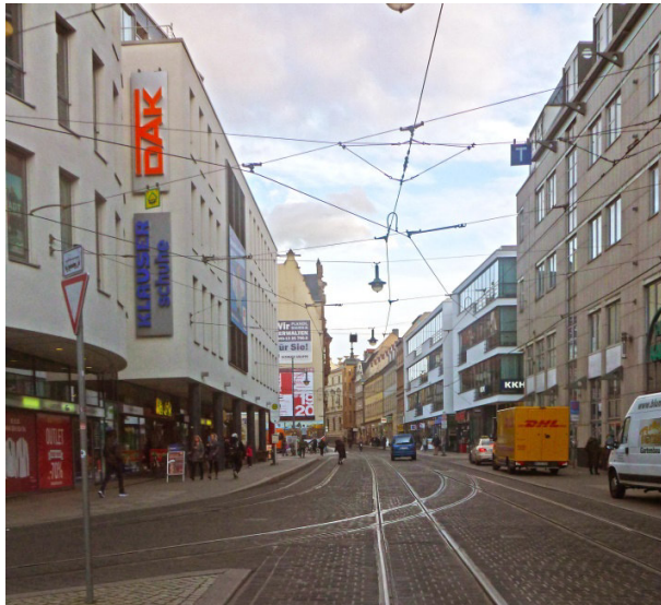
↑ Büro- und Einzelhandelsgebäude in der Großen Steinstraße: Die Neubauten orientieren sich am Stadtgrundriss. (4)
