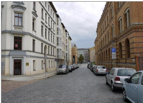
Charlottenstraße Richtung Süden
