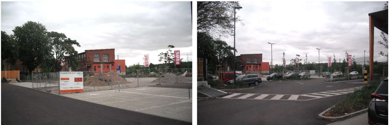
Abbildung 1: Objektsituation auf dem Projektgrundstück Merseburger Straße 401 in Halle
