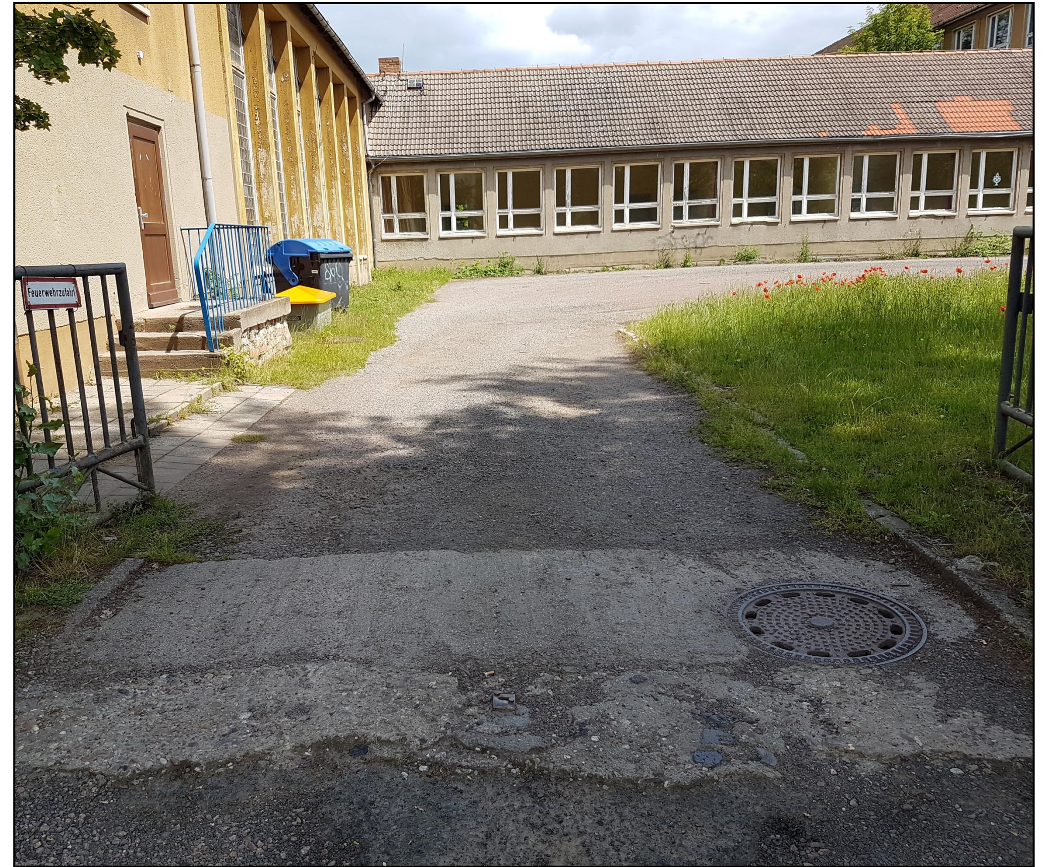
Zufahrtsbereich Feuerwehr und westlicher Schultrakt / Turnhalle
