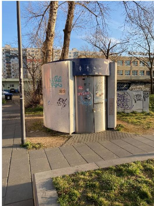
6. **Mauerstraße** – Die eingebaute technische Anlage ist aufgrund ihres Alters (ca. 25 Jahre) verschlissen und damit in einem sehr schlechten Zustand. Notwendige Reparaturen sind sehr kostenintensiv. Eine Erneuerung der Anlage ist mittelfristig notwendig. Der bauliche Zustand ist in Ordnung.
