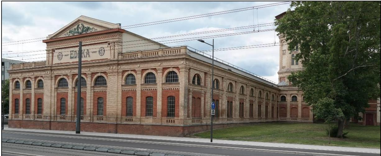
Sanierte Fassade der durch monumentale Rundbogenstellungen hervorgehobenen, dreischiffig basilikal aufgebauten Maschinenhalle, 1896/97 von der Baufirma Fritz Schönemann und Günter Schwarz entworfen und im rechten Winkel zur Dreherei errichtet (Foto FB Städtebau und Bauordnung)
