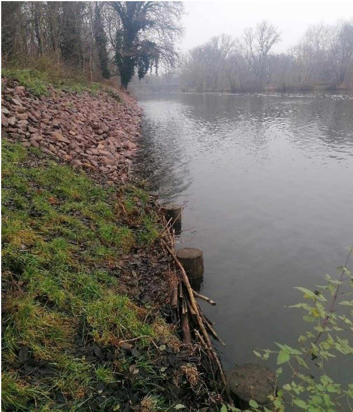
Abbildung 1 Ökologische Ufersanierung an der Schleuse Gimritz, im Hintergrund aktuelle Steinschüttungen, Foto: Rohrbach.
