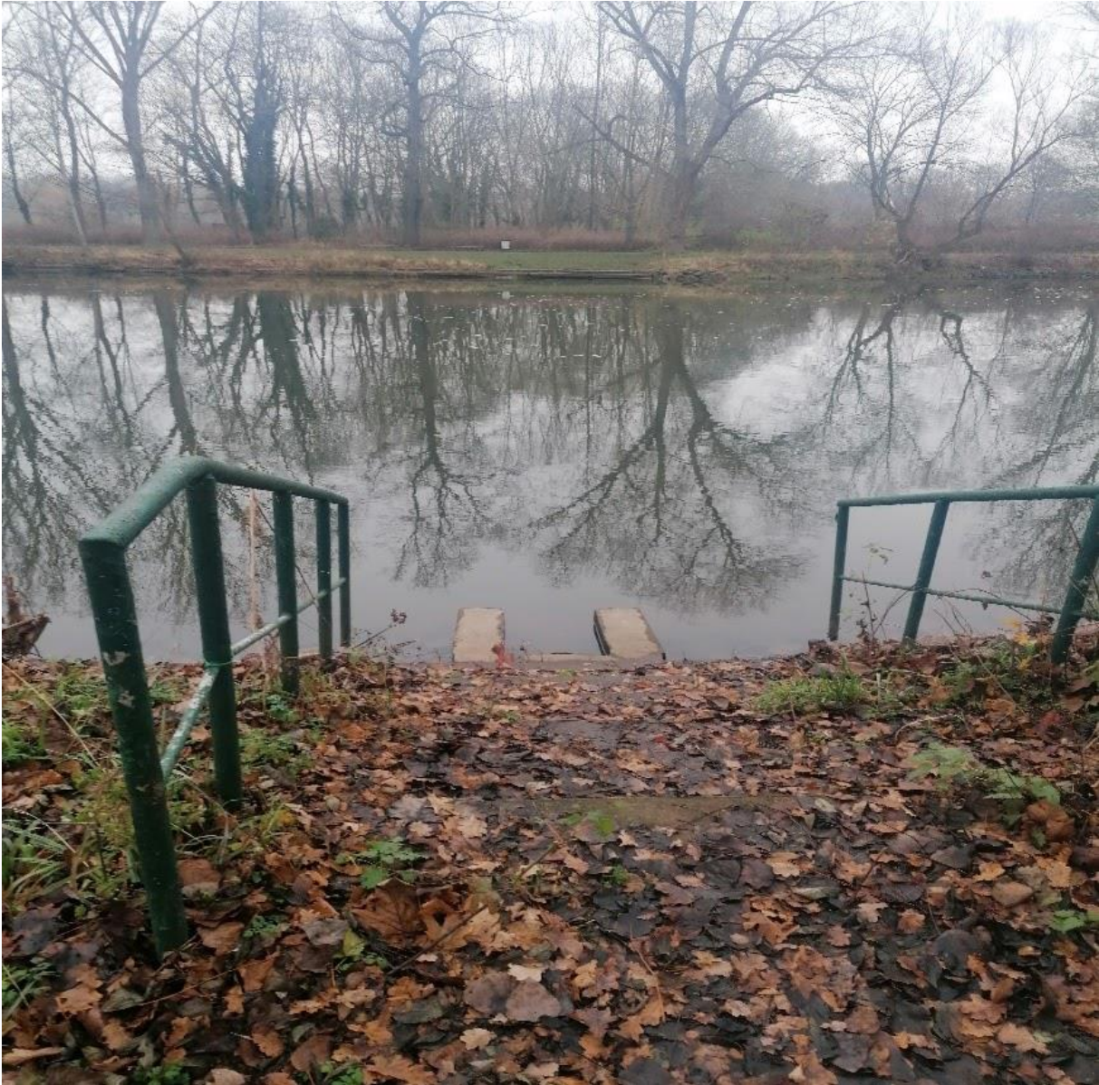
Abbildung 5 Fähranleger an der Peißnitzinsel. Wurde 2019 im Zuge der Testphase „Wassertaxi“ von allen Fahrgästen als tolle Lösung gesehen. Gegenüber ist der zweite Anleger an der Ziegelwiese, Foto: Rohrbach.
