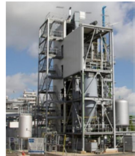
Bild der Testanlage (Schlackebadvergaser SBV)
