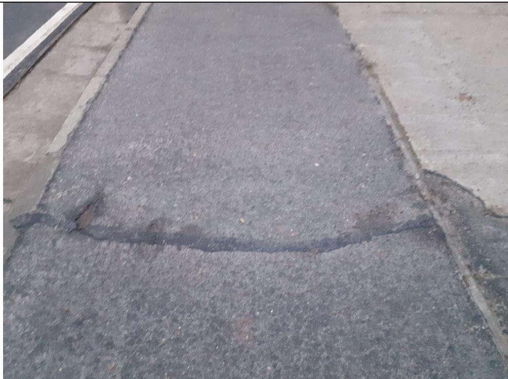
Einzel Schaden, Fugenverguss gerissen, nicht sicherheitsrelevant
