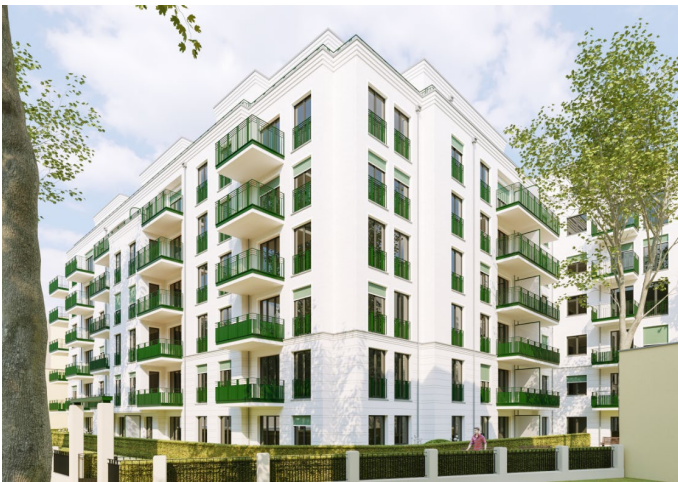
Berliner Straße, Berlin (im Bau)
