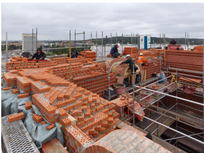
Garnisonkirche, Potsdam (im Bau)
