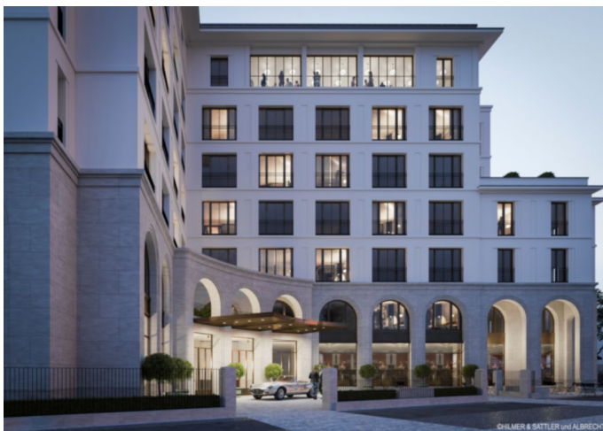
Hotel Tiergartenstr., Berlin (im Bau)
