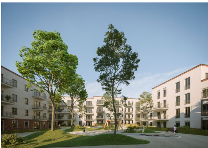
Solingen (im Bau)
