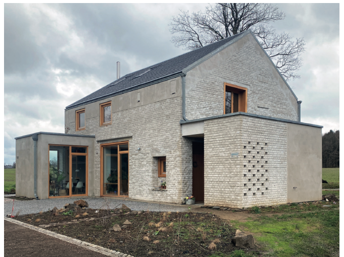
„Wohnen in der Scheune, Oelsnitz/Erzgeb.“ Objektplanung Hochbau und Freianlagen abgeschlossen
