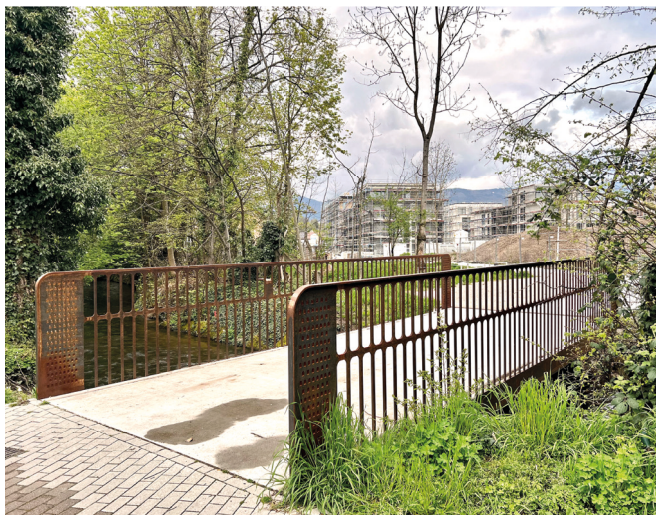
„Brücke im Landschaftspark Illenauwiesen, Achern“ Objektplanung Freianlagen Kooperation mit Bildhauerin Anne Schäfer
