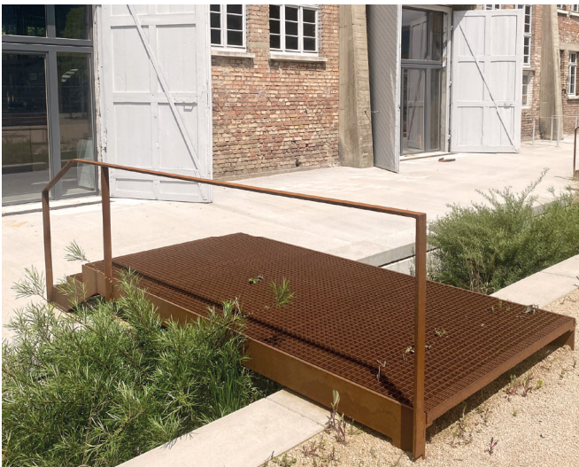
„Reithallenplatz Illenaawiesen, Achern“ Objektplanung Freianlagen in Bauabschnitten derzeit LPH 8
