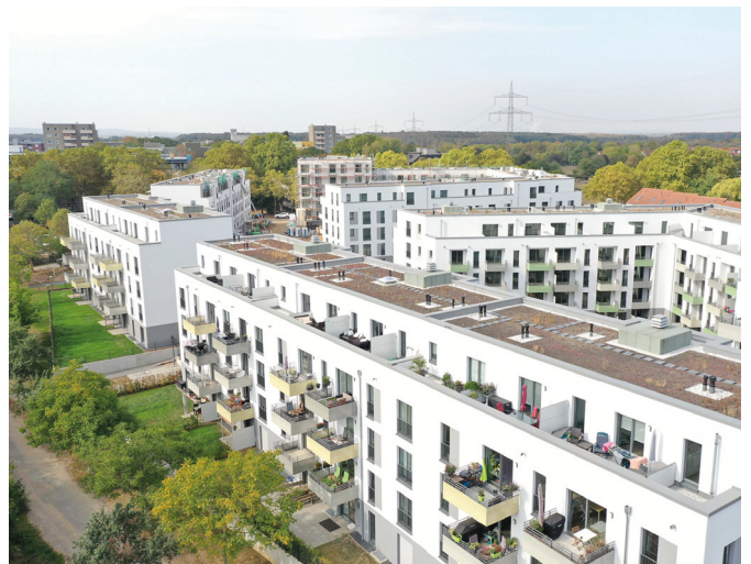
„Swinstraße, Köln Chorweiler“ Planungsleistung Hochbau und Freianlagen abgeschlossen
