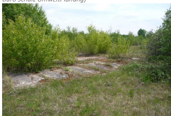
Abbildung 5: Betonplatten im Boden mit Ruderalfluren im Vordergrund und Sukzessionsgehölze im Hintergrund (13.05.2020, Büro Schulz UmweltPlanung)
