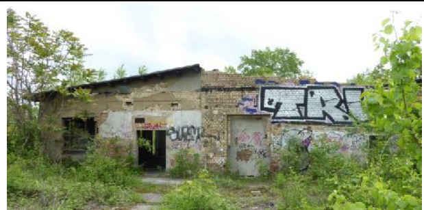
Gebäuderuine im Zentrum der Brachfläche
