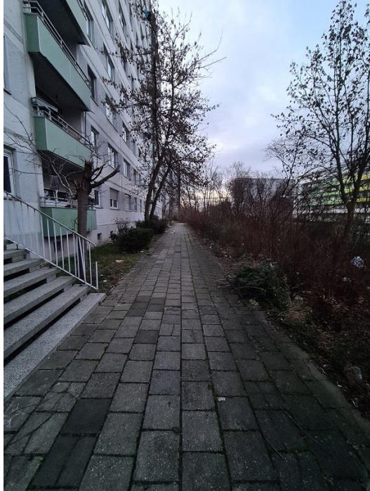
Rückseite 11-Geschosser an der Feuerwache – Gesamtansicht (21.12.24)
