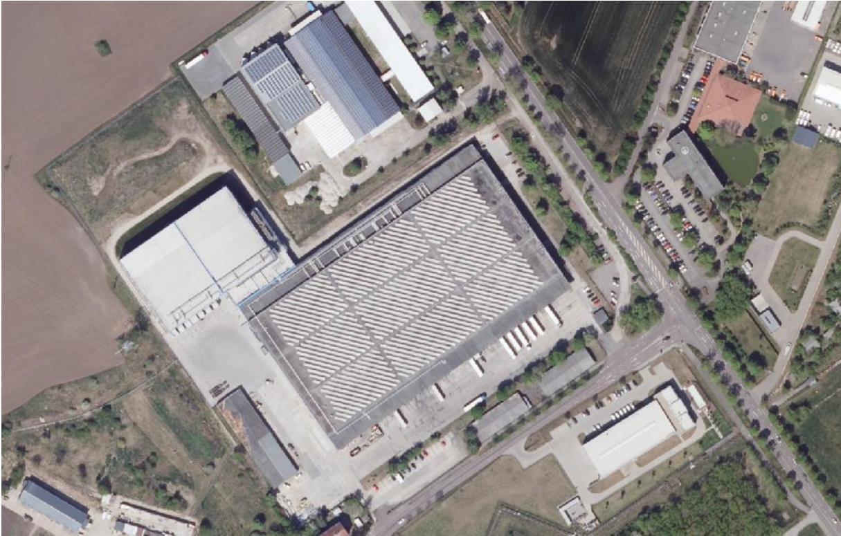
Abbildung 11: Dachflächen-Photovoltaikanlage auf einem Gewerbebetrieb an der Magdeburger Chaussee.
