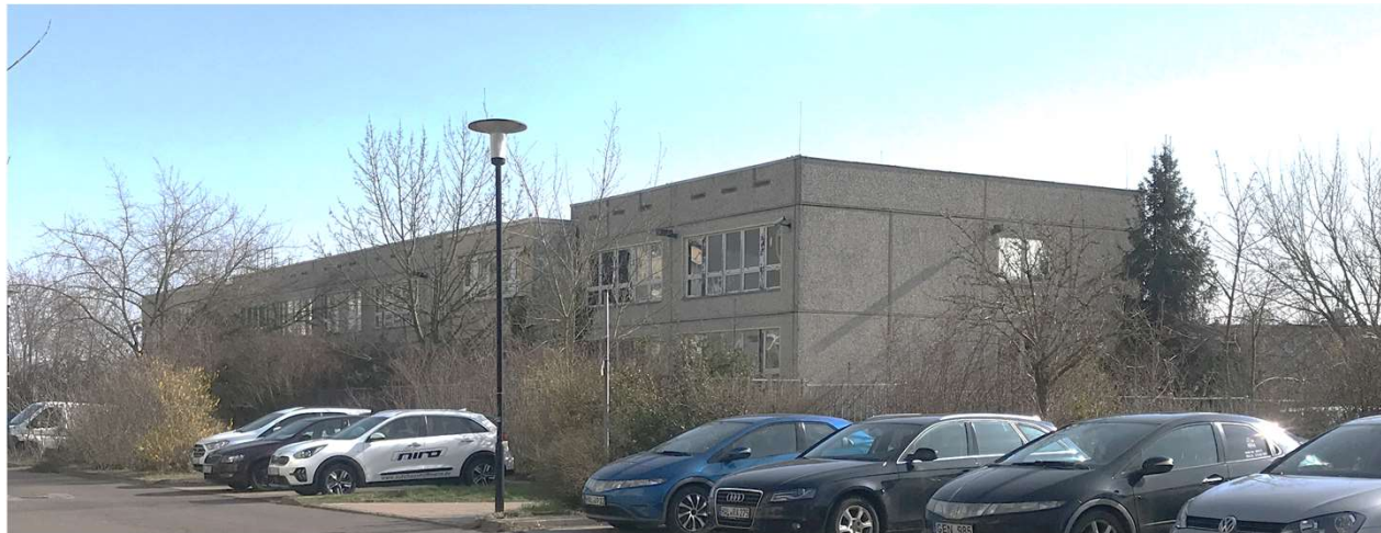
Bestand Nordwest - Straßenseite
