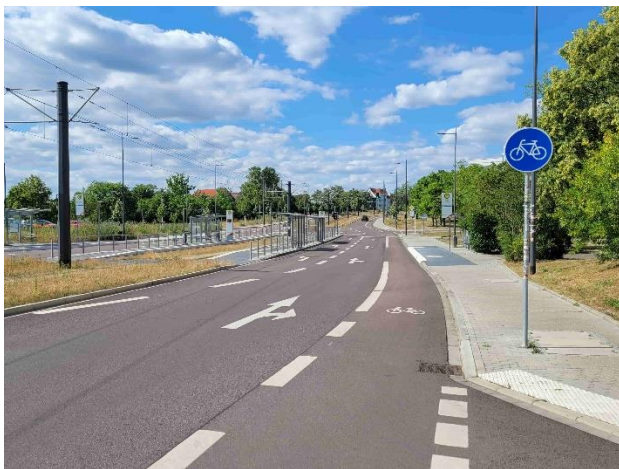
Radfahrstreifen im Südstadtring
