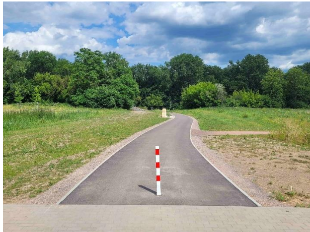
Weg zwischen Gimritzer Damm und Bürgerbrücke/ Peißnitzinsel
