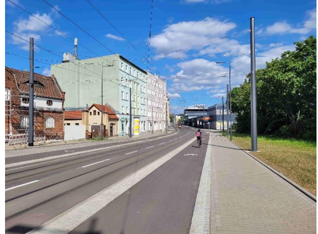
Radweg in der Mansfelder Straße
