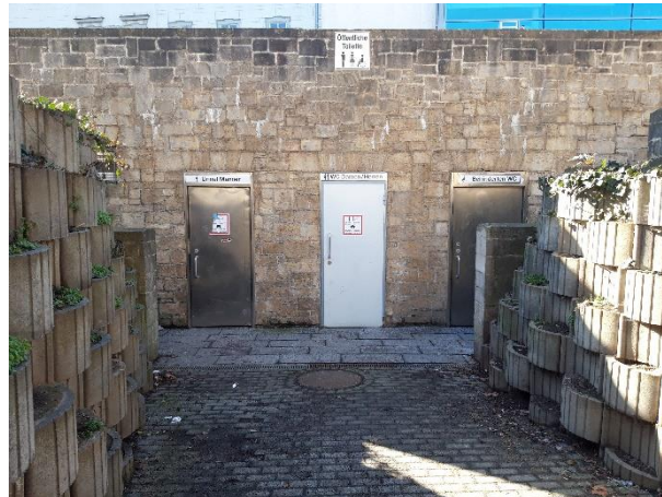
Abbildung 6: Südliche Innenstadt, Mauerstraße 17
