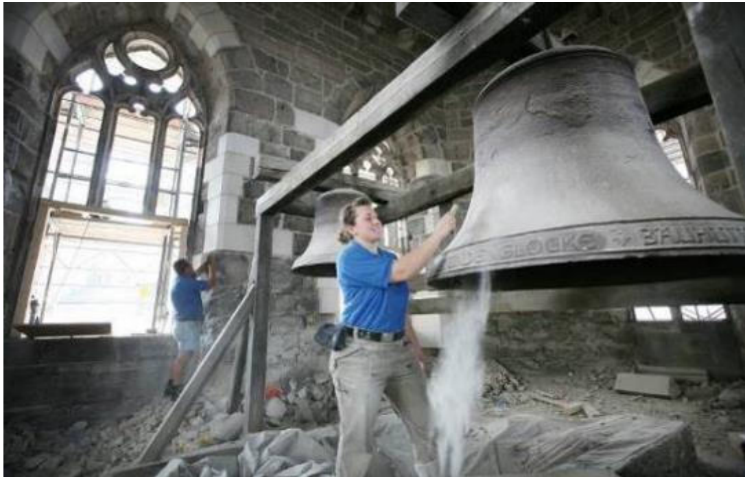
Abbildung 36: Roter Turm während der Sanierung (2007) [Ziegler]
