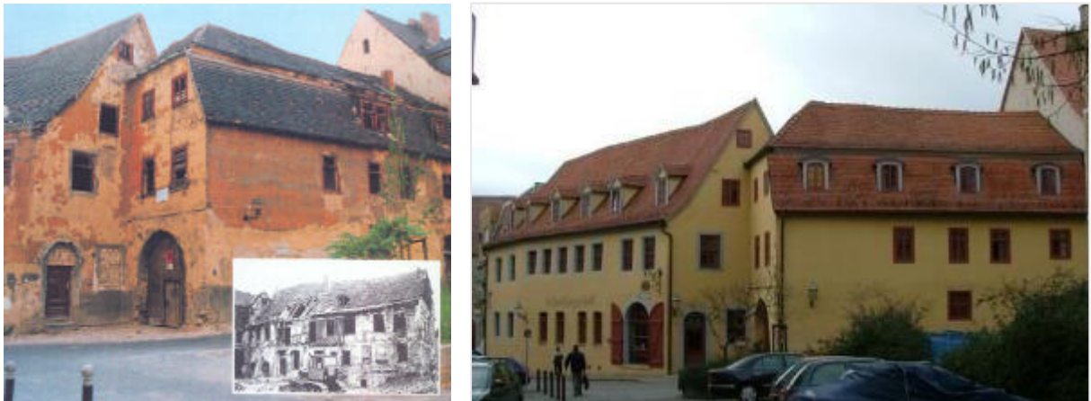
Abbildung 96: Große Klausstraße 14 – Ackerbürgerhof vor und nach der Sanierung
