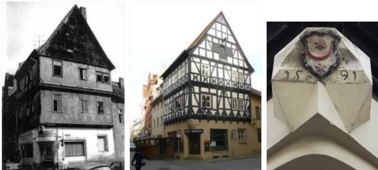
Abbildung 32: Kleine Ulrichstraße vor der Sanierung und heute sowie ein Detail der Fassade (v. l. n. r.)
