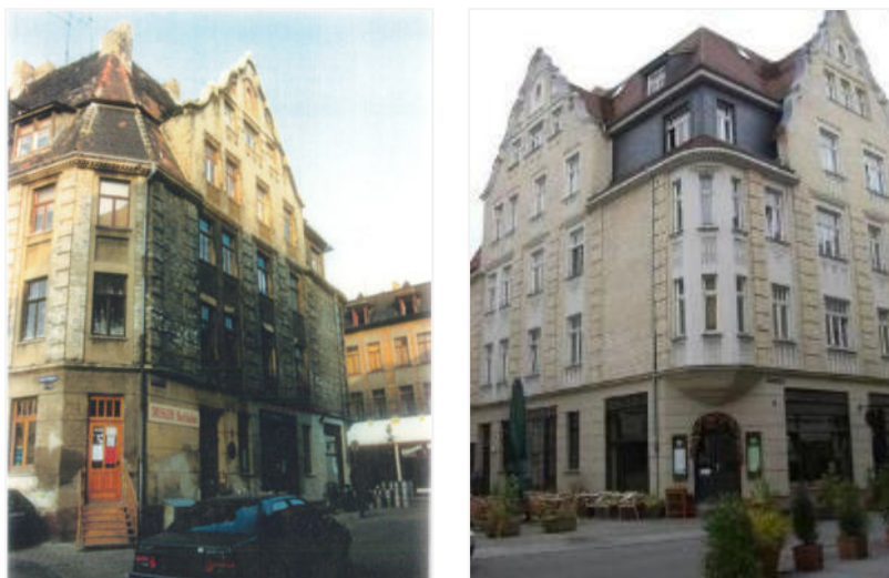
Abbildung 33: Kleine Ulrichstraße 12 im Jahr 1992 und nach der Sanierung (v. l. n. r.)
