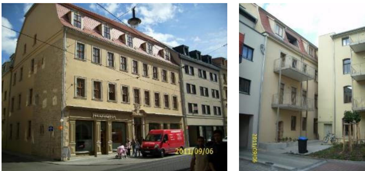
Abbildung 100: Gebäude nach der Sanierung
