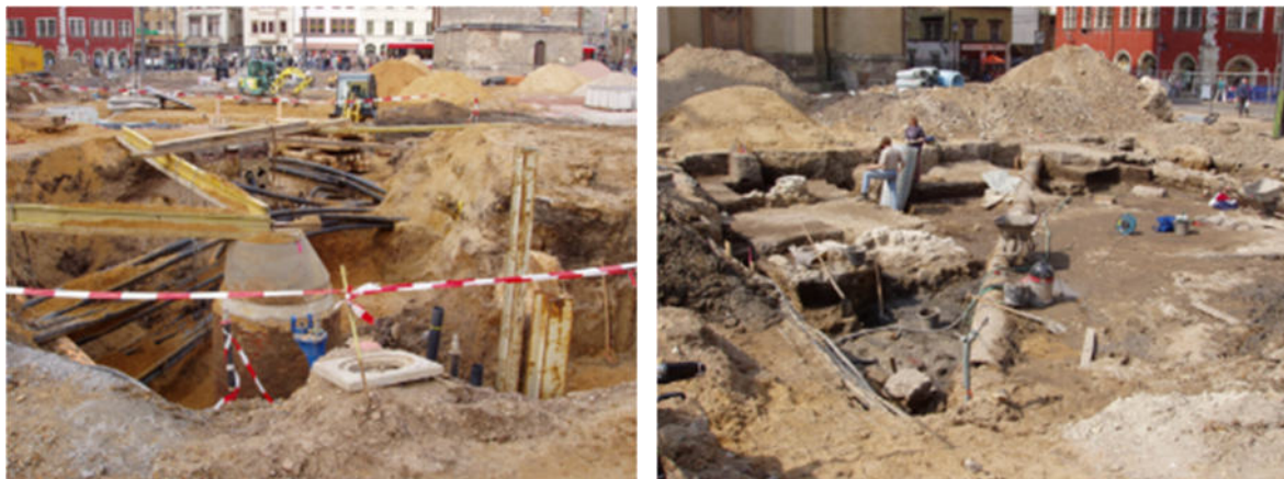
Abbildung 92: Tiefbaumaßnahmen Ver- und Entsorgungsträger auf dem Marktplatz
