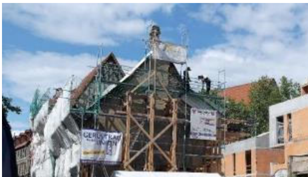
Abbildung 65: Richtfest in der Mittelstraße
