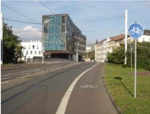
Foto 1: Radfahrstreifen in der Mansfelder Straße
