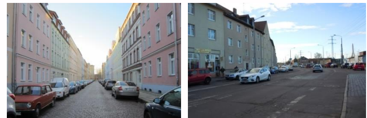
Pflasterbelag in der Friesenstraße, schadhafter Belag in der Berliner Straße, Fotos: LK Argus
