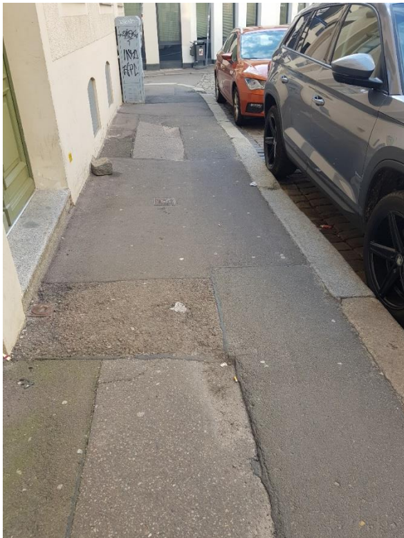
Gustav- Anlauf-Straße • Südlicher Gehweg
