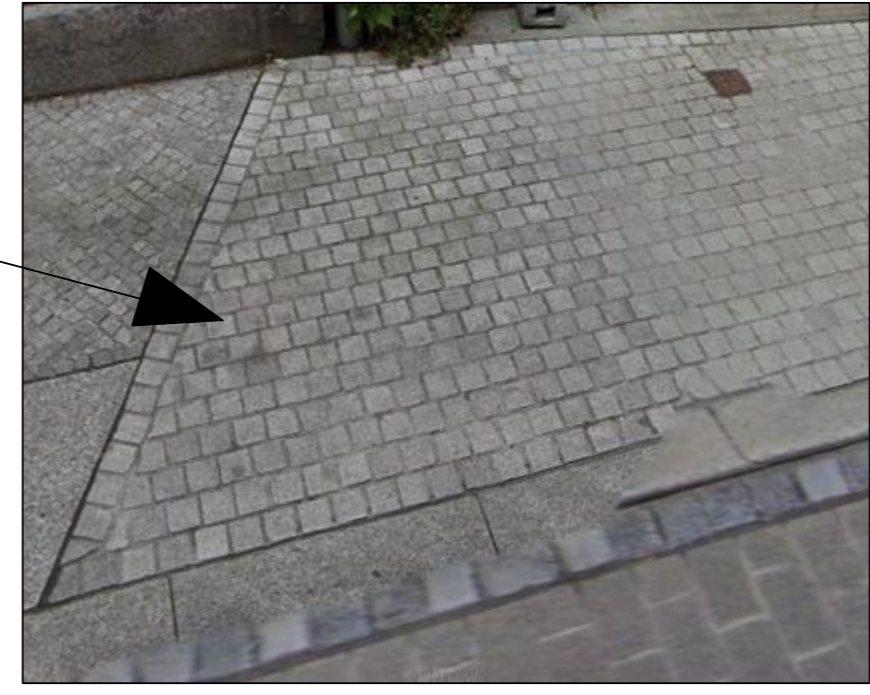
Gehweg Einfahrt/Ausfahrt Granit Kleinsteinpflaster Reihenverband
