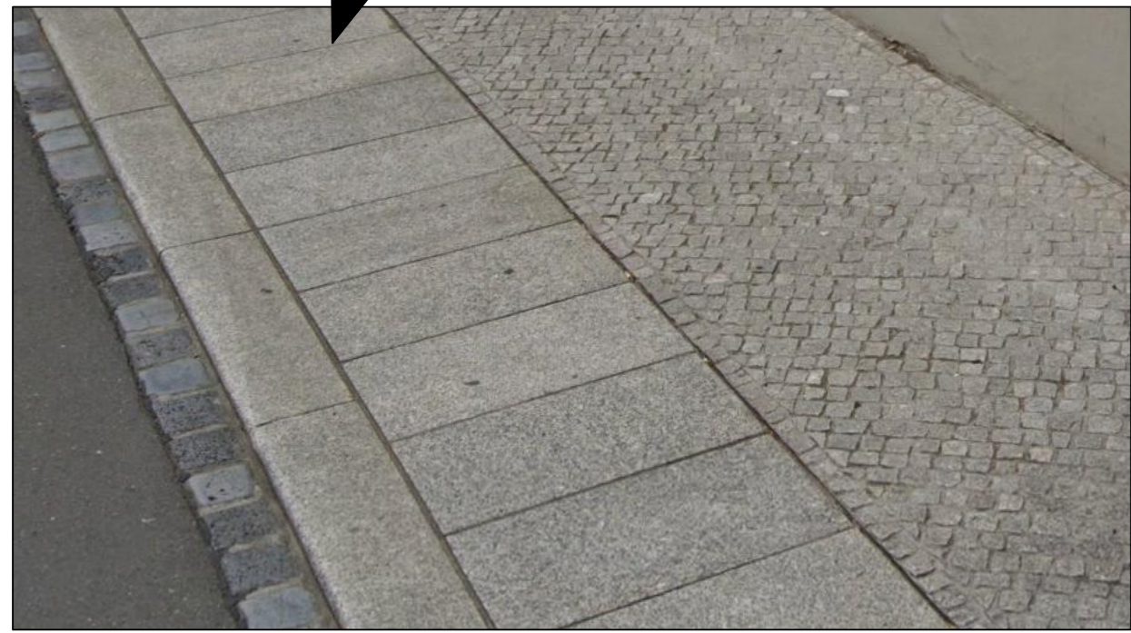
Gehweg Granitplatten Reihenverband
